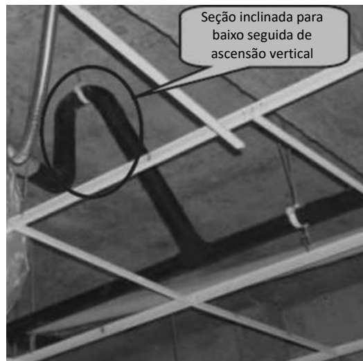
Figura 3-6.7: Seção inclinada descendente da tubulação de drenagem
