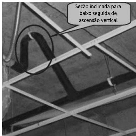
Figura 3-6.7: Seção inclinada descendente da tubulação de drenagem
